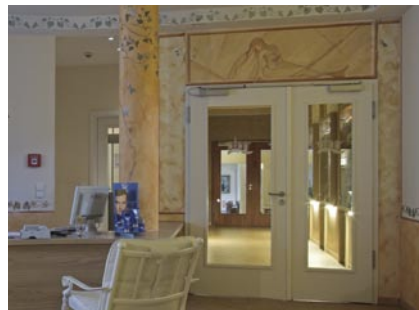
Rezeption im Wellnessbereich: Zweiflügeliges MORALT T-30 Brandschutzelement mit Lichtöffnung und Obentürschließen
